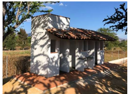
Zisterne und Trockentoiletten – jetzt fertig
