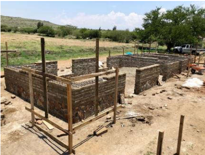
Erste Arbeiten am Essensraum
