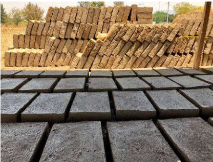
Herstellung der Adobe-Bausteine
