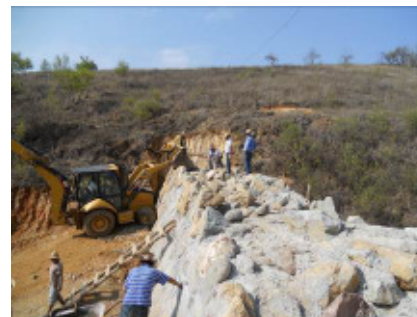
Während der Bauarbeiten ...
