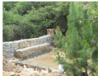
Staustufe „Gaviones del filón“
