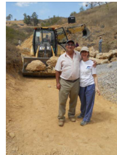
Luz Elena und Antonio auf der Baustelle
